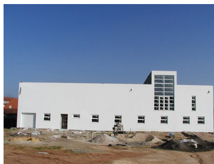
Fig. – Edifício Municipal em Freixianda
